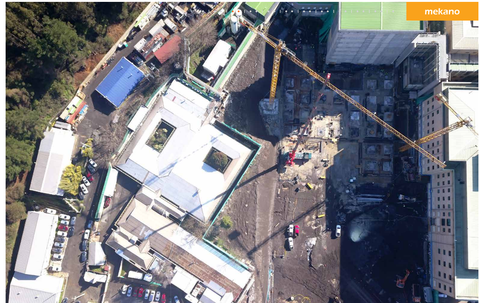
En el último tiempo estamos muy enfocados y especializados en la construcción de hospitales. Estamos en San Antonio, en Talcahuano y en Chiloé”, Erich Strelow, Subgerente de Sistemas de Moller & Pérez-Cotapos.
